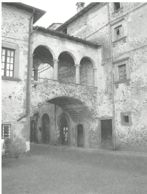
Filetto. La bella loggia sotto cui passa la via centrale del piccolo borgo, dalla regolare pianta quadrilatera
